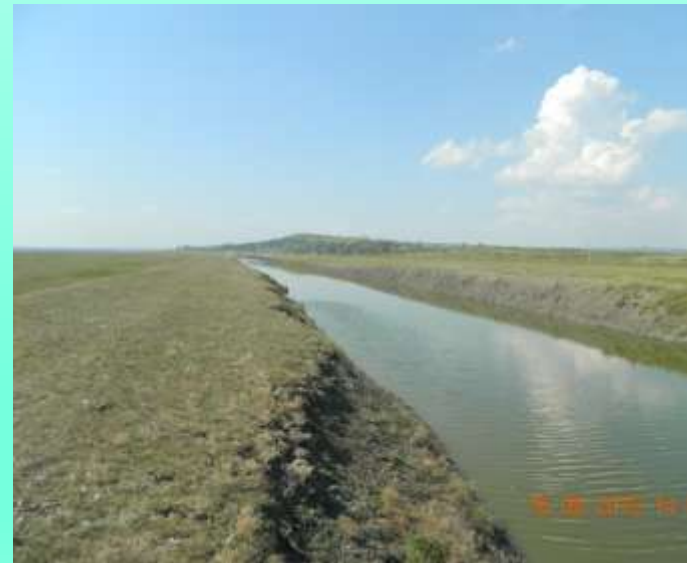
Râul Camenca transformat în canal în apropiere de s. Pruteni
